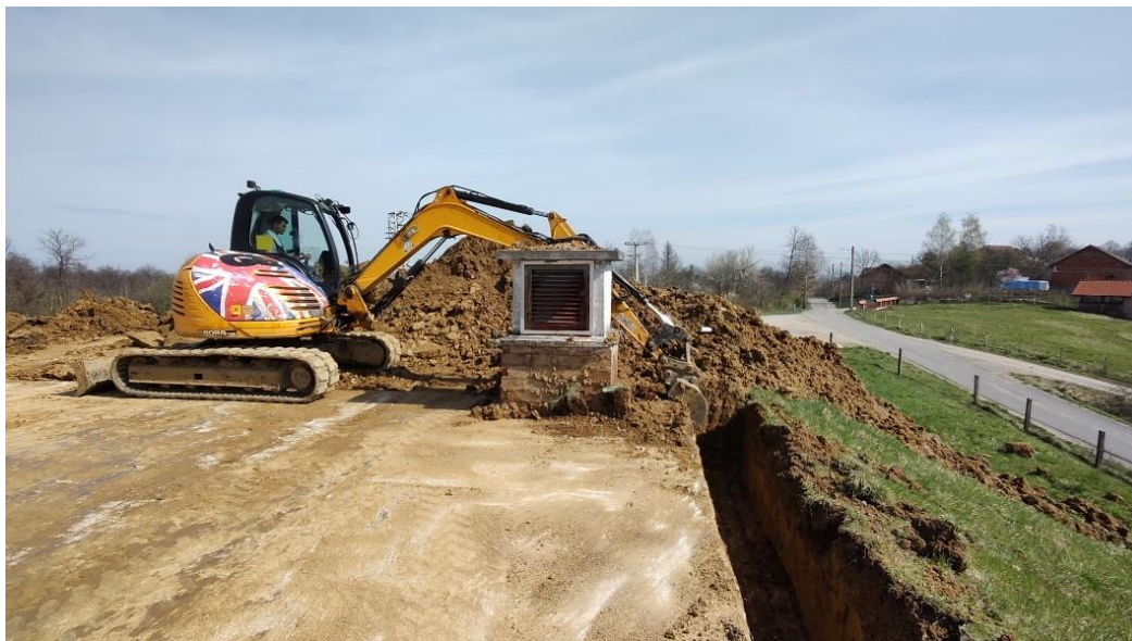
Slika 60. Radovi sanacije štete na vodocrpilištu Novo Selište
