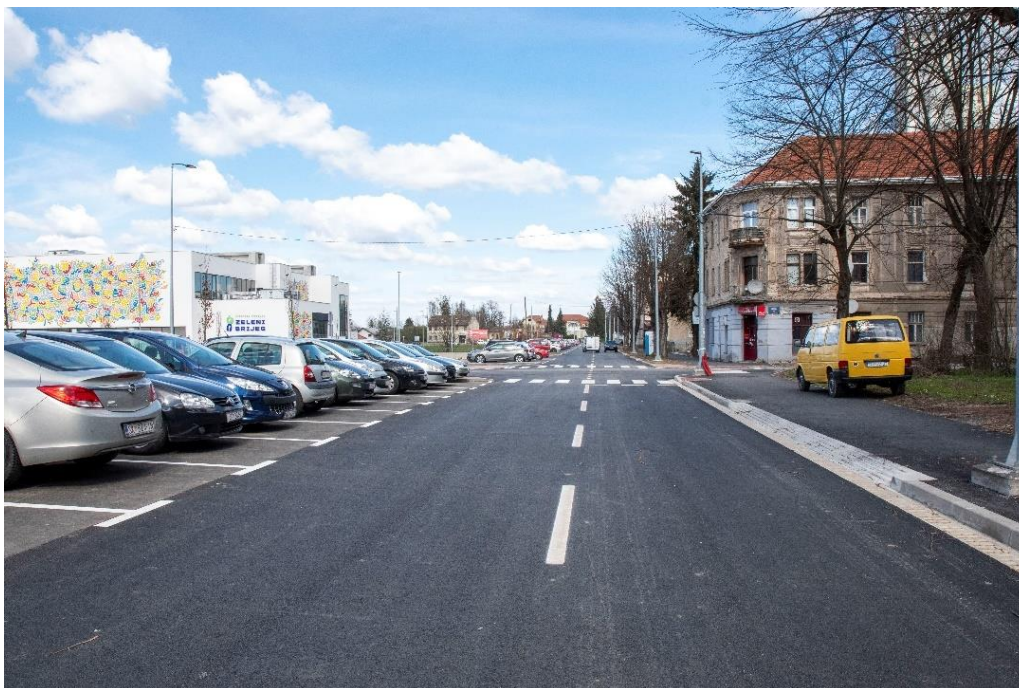
Slika 59. Rekonstruirana Ulica kralja Zvonimira
