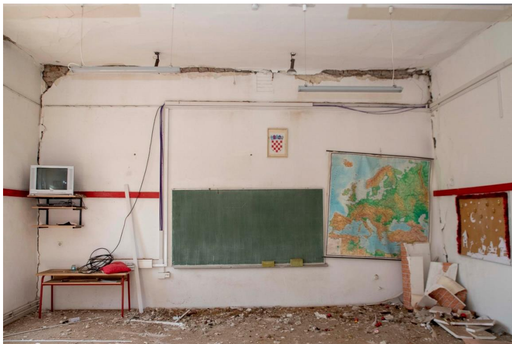
Slika 11. OŠ Topolovac prije obnove
