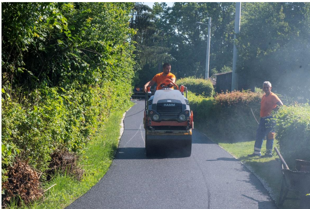
Slika 48. Novi asfalt na području sela Jazvenik
