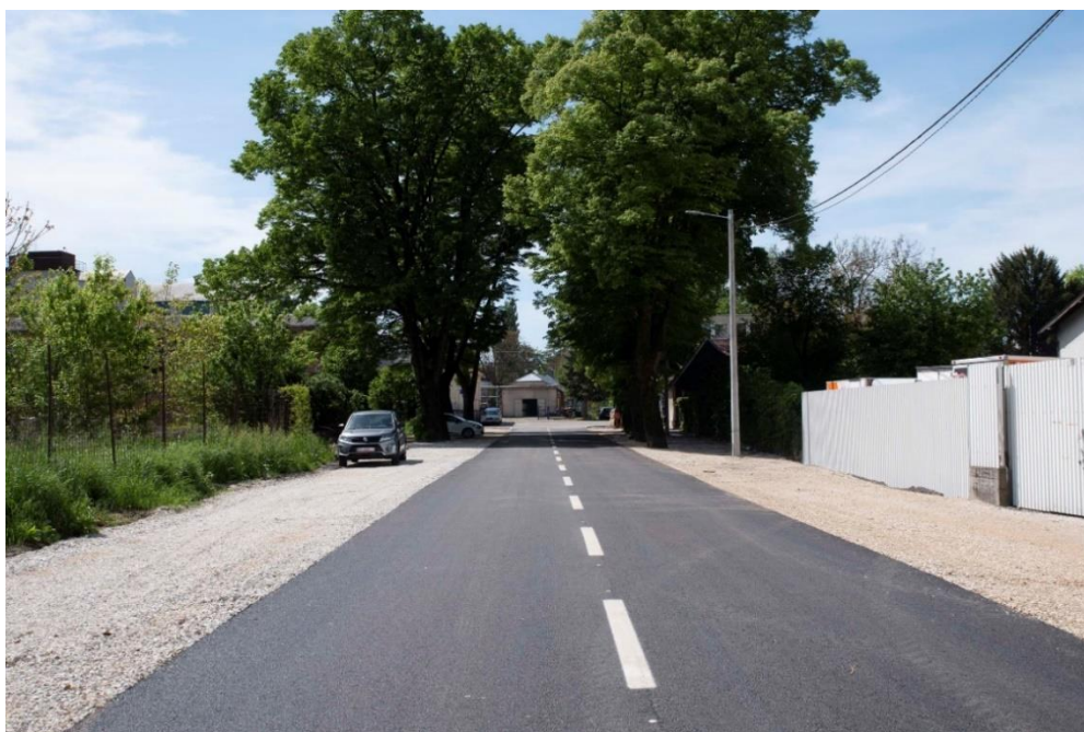
Slika 20. Sanirana prometnica u Ulici Vatroslava Jagića
