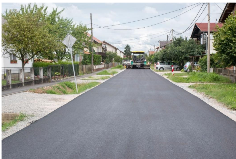
Slika 62. Asfaltiranje Poljske ulice
