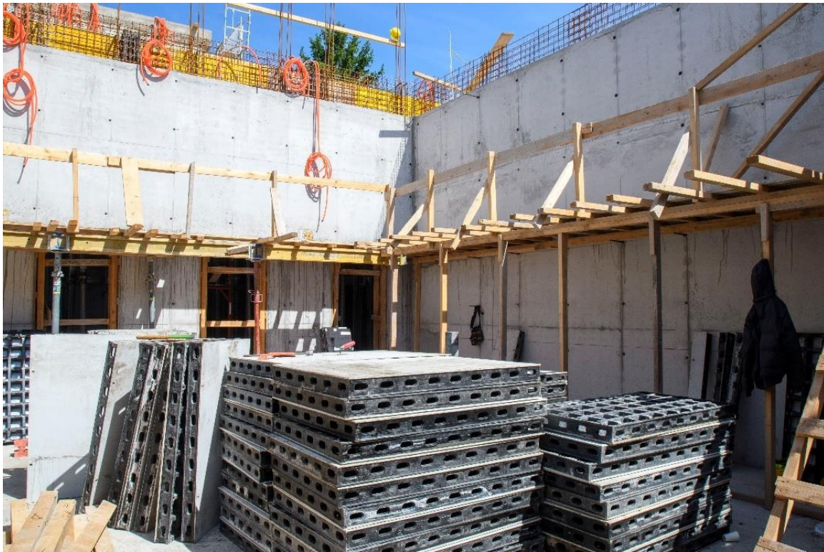
Slika 68. Radovi rekonstrukcije na Munjari
