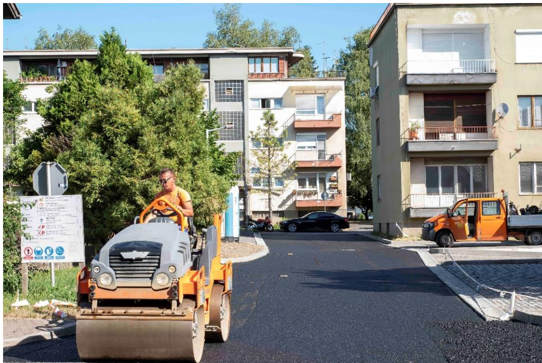
Slika 24. Radovi na Trgu hrvatskih branitelja
