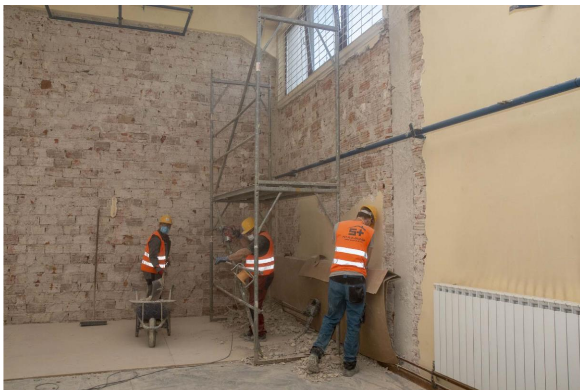
Slika 46. Radovi na obnovi OŠ Viktorovac
