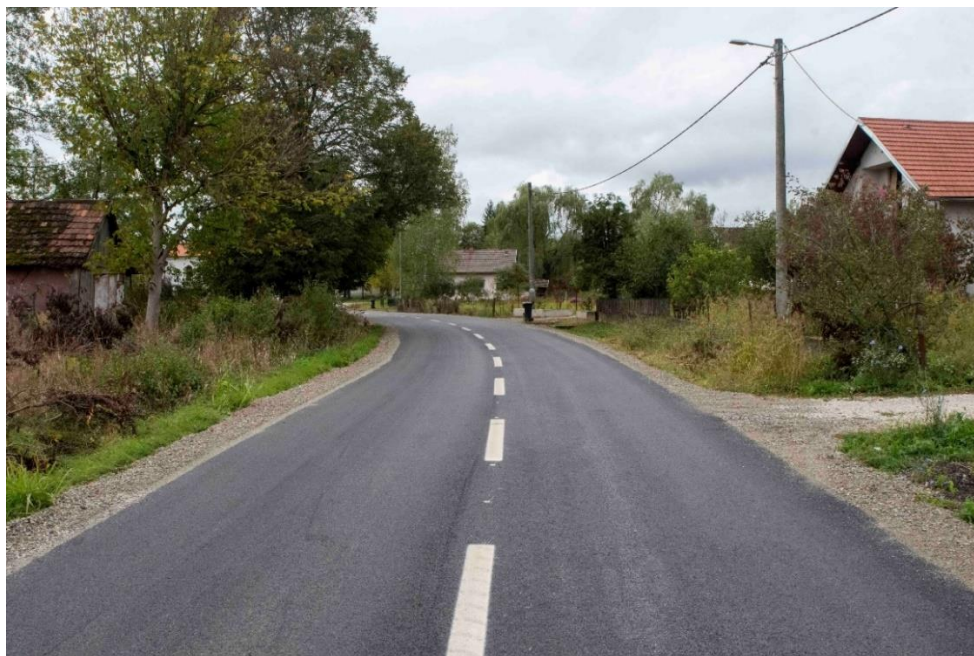
Slika 36. Novi asfalt na prometnici Madžari-Letovanci
