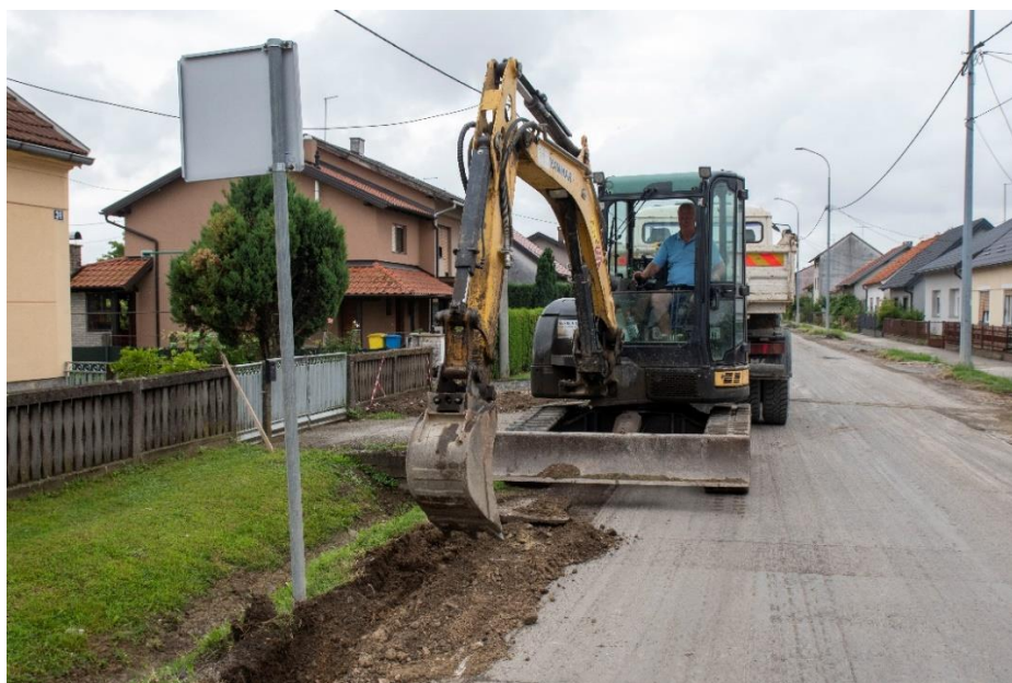
Slika 61. Radovi na rekonstrukciji Ulice Brezovičkog odreda
