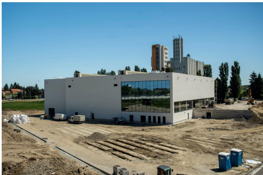
Slika 16. Završna faza izgradnje sportske dvorane Zeleni brijeg
