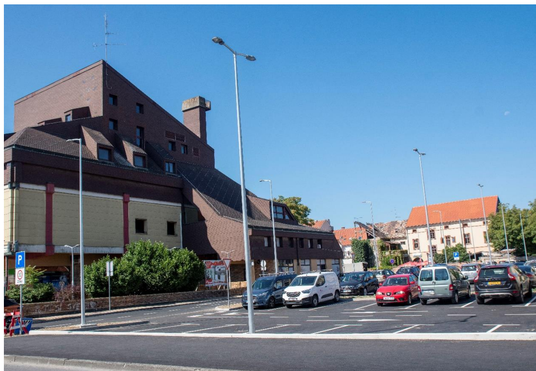
Slika 51. Završeni radovi na parkiralištu kod GRAME
