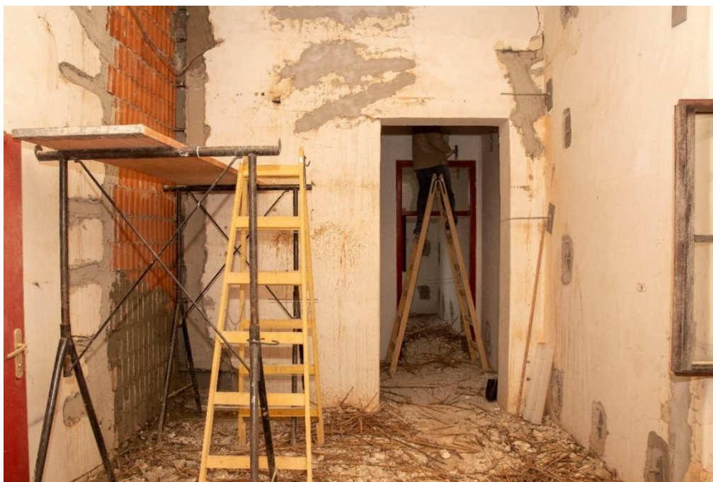
Slika 43. Radovi obnove u OŠ Topolovac
