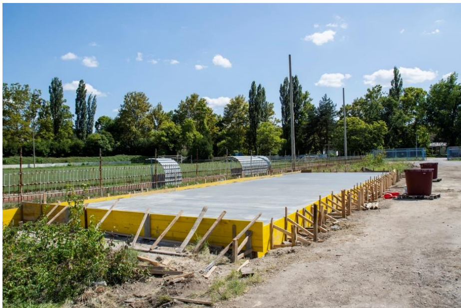
Slika 31. Radovi na izgradnji tribina na stadionu Matalca
