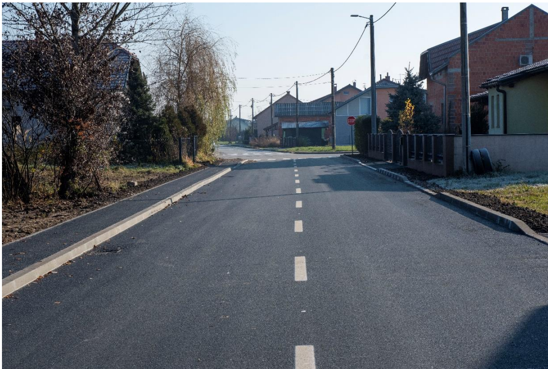
Slika 38. Novi asfalt u Slavonskoj ulici
