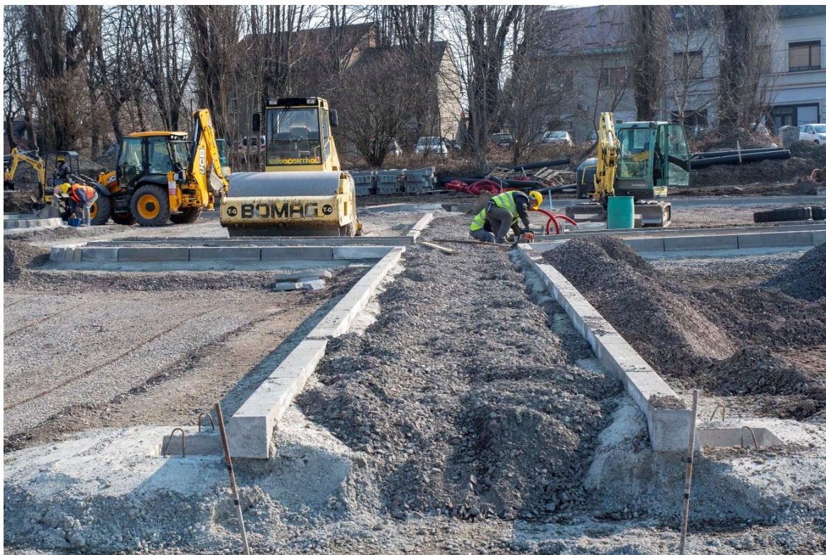
Slika 41. Radovi na PARK&RIDE parkiralištu
