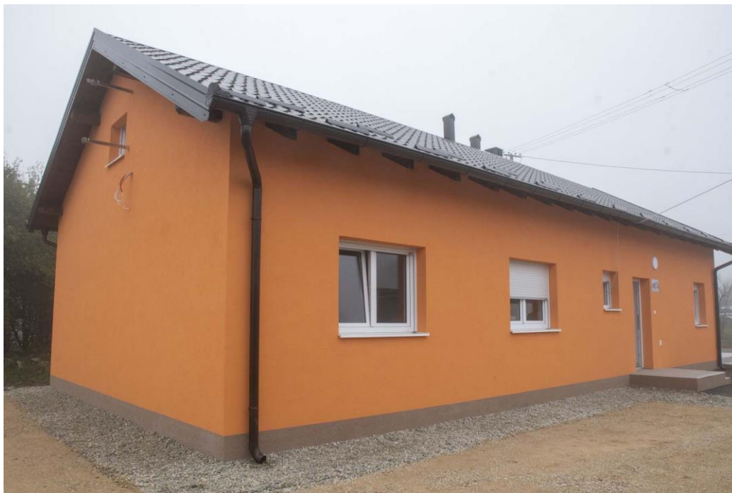
Slika 55. Izgrađena prva zamjenska kuća u Galdovu
