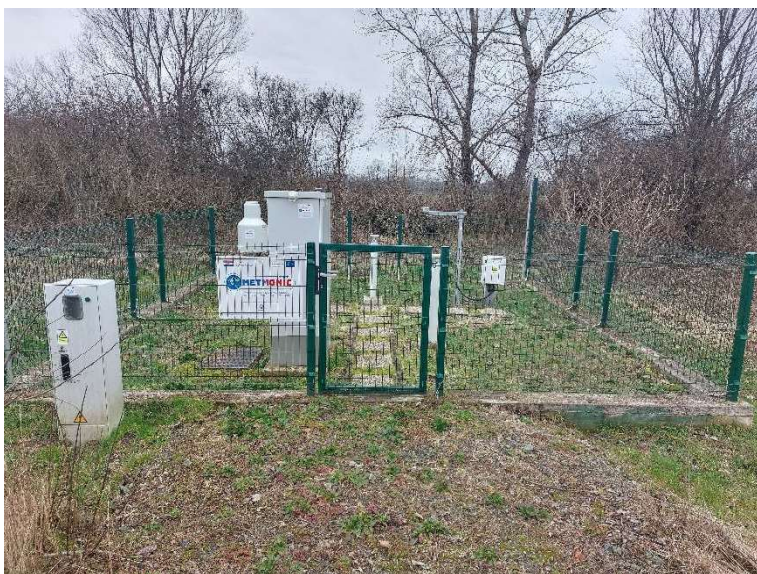
Slika 46. Izgrađena meteorološka stanica u Jasenovcu Izvor: ZPUSMŽ
