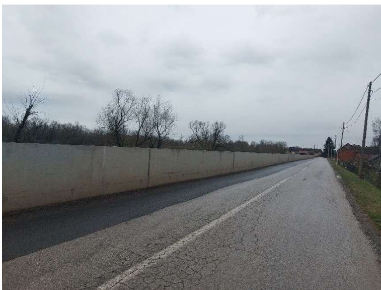
Slika 45. Izvođenje zahvata na obrani od poplave u Uštici, Tancu, Košutarici, Mlaci i Višnjici - betonski nasip u naselju Tanac Izvor: ZPUSMŽ
