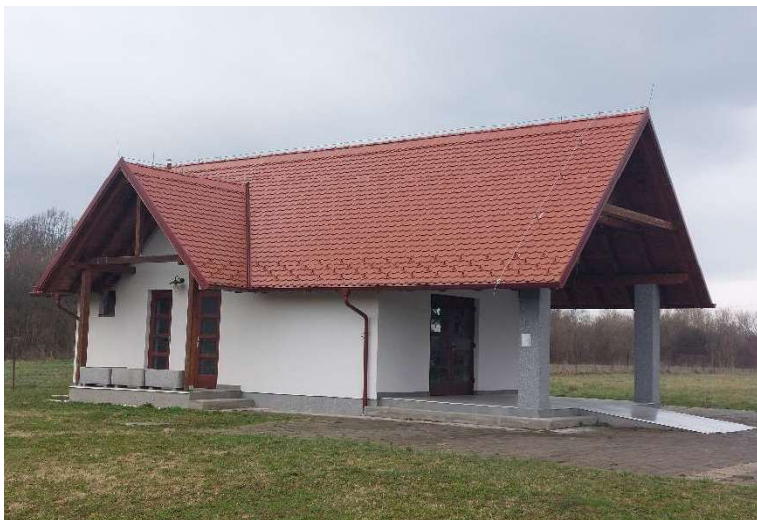
Slika 47. Izgrađena i opremljena mrtvačnica u naselju Tanac Izvor: ZPUSMŽ
